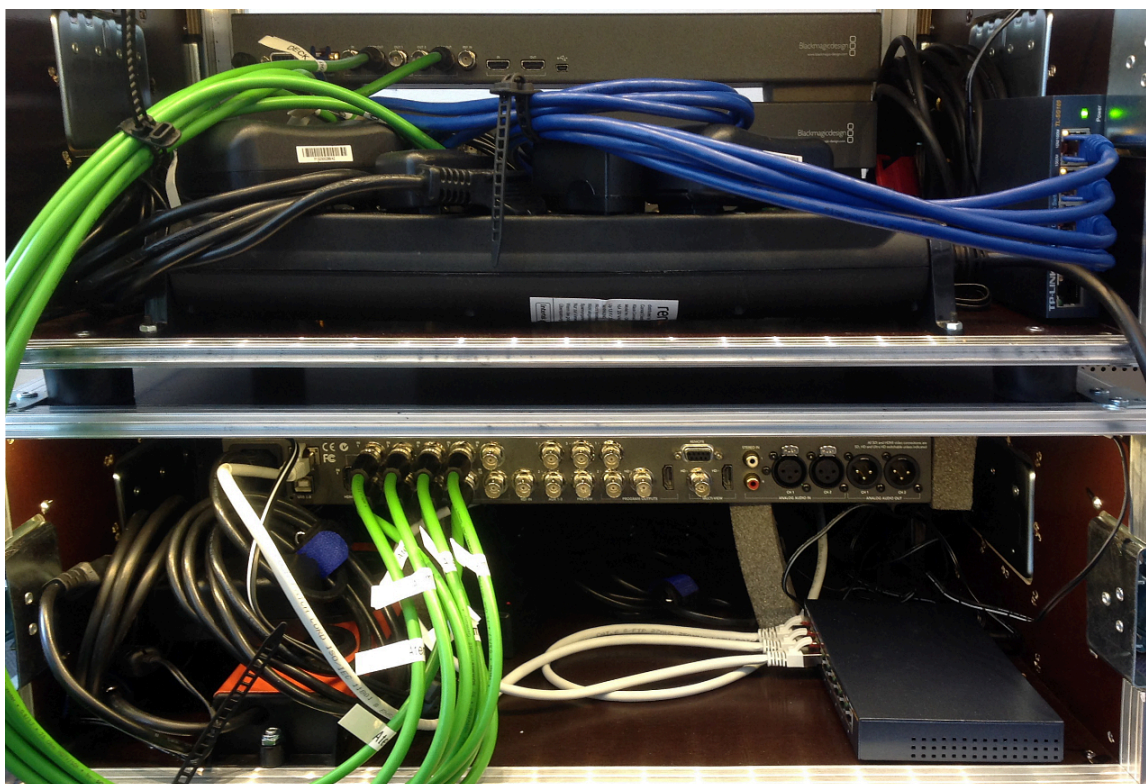
Beispiel für eine Verkabelung von mehreren Hyperdecks mit einem ATEM Bildmischer (grüne Kabel) und einem LAN Netzwerk (blaue Kabel)
